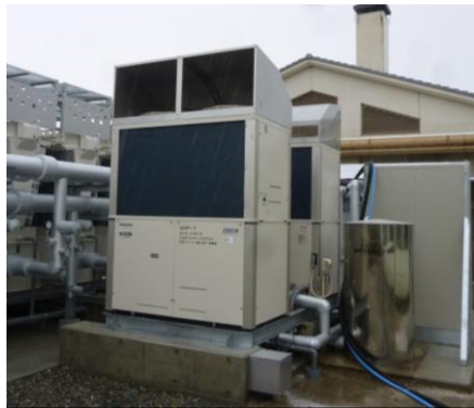
空調設備（左 ガスヒートポンプエアコン、右 高効率モジュールチラー）
