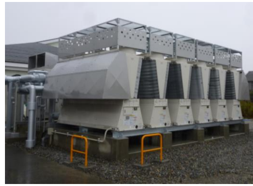
空調設備（左 ガスヒートポンプエアコン、右 高効率モジュールチラー）
