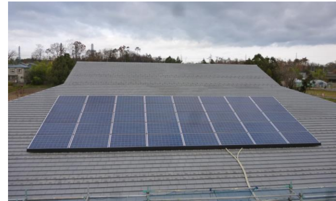
太陽光パネル設置状況
