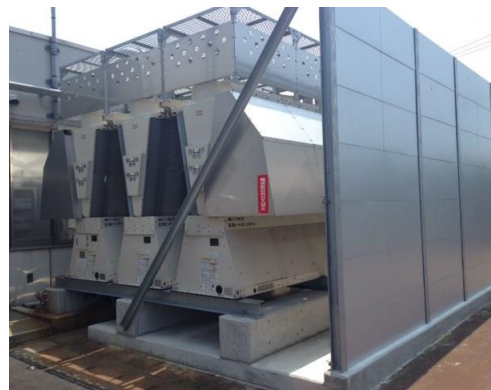
空調設備（左 ガスヒートポンプエアコン、右 高効率モジュールチラー）
