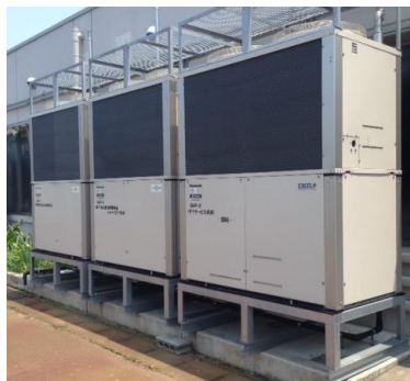
空調設備（左 ガスヒートポンプエアコン、右 高効率モジュールチラー）
