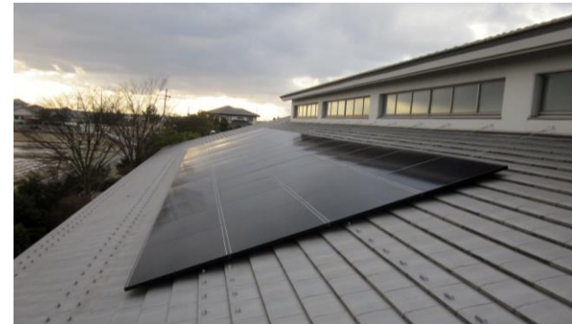
太陽光パネル設置状況
